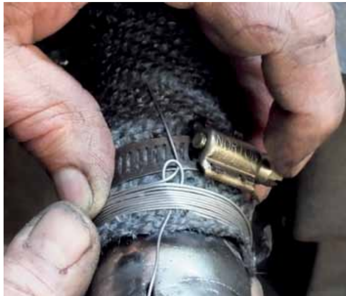
Das andere Ende vorsichtig beiziehen, bis die Öse unter der Wicklung verschwindet
